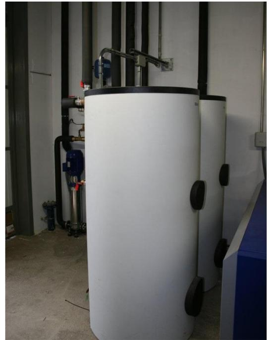
Además, la instalación está preparada para que la energía almacenada en estos dos depósitos contribuya a otras partes del proceso de elaboración del queso, como el requesón y, además, puedan climatizar determinados lugares de la nave industrial a través de aerotermos.
