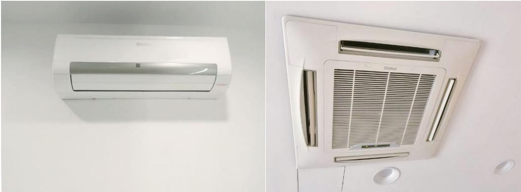
En las zonas comunes, por el contrario, se optó por la instalación de modelos cassette, con los que, gracias a sus cuatro salidas de aire ubicadas en los costados, se alcanza una óptima distribución del aire garantizando el máximo confort.
