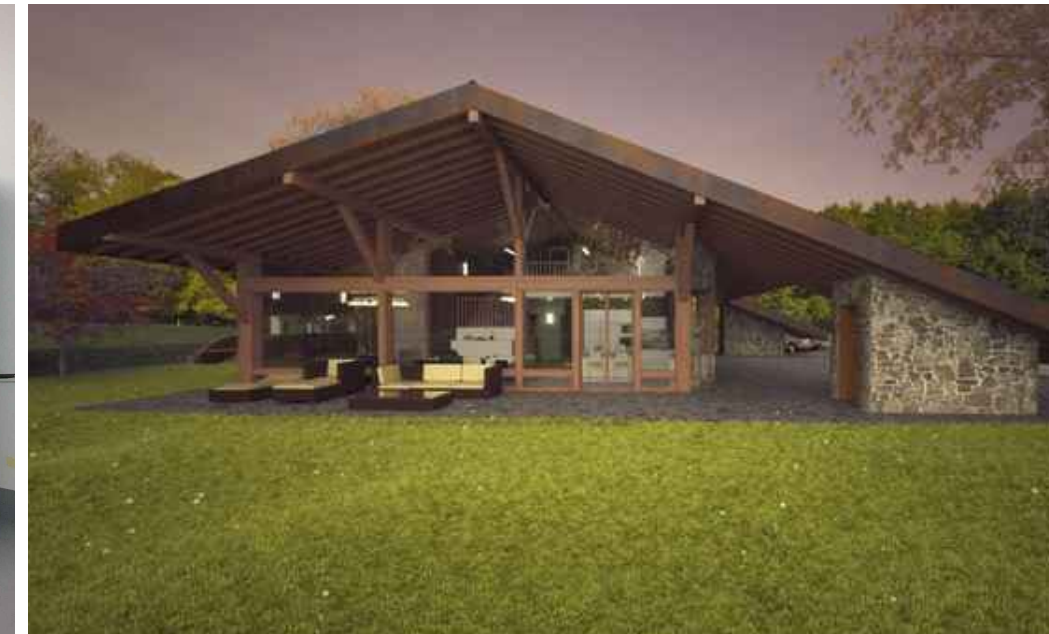
Vivienda unifamiliar en Navarra
