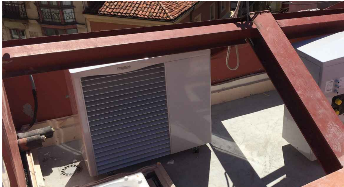
Edificio de 10 viviendas en Gijón
